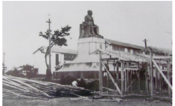
コンクリート製の渋沢栄一像 昭和18(1943)年ごろ 戦時中の金属供出のため、銅像は別の場所に置かれていた。 (東京都健康長寿医療センター所蔵写真)
