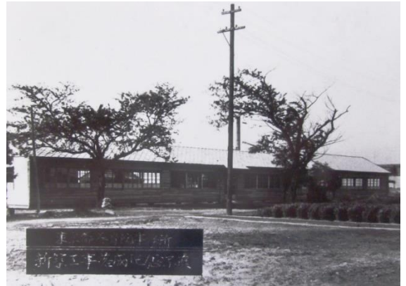
養育院本院 事務所 昭和23(1948)年 (東京都健康長寿医療センター所蔵写真)
